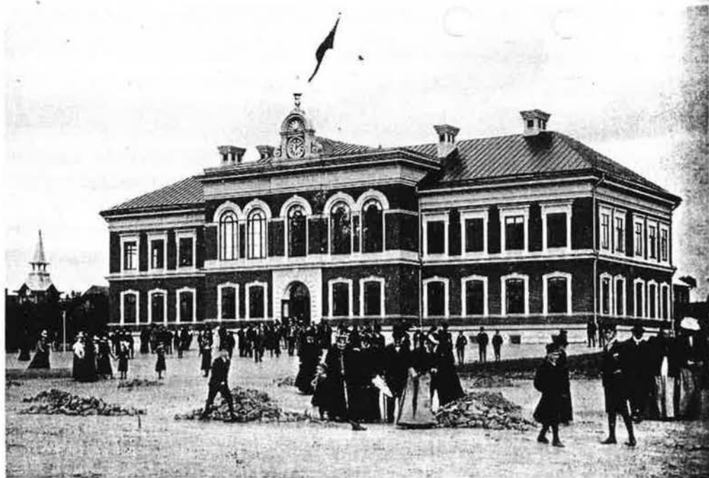
"Nya läroverket" i Östersund invigdes 1897. Byggnaden hade ritats av stadsingenjör Adolf Kjellin, som under åren kring sekelskiftet stod bakom flera offentliga byggnader i Östersund, bl a Södra skolan.
